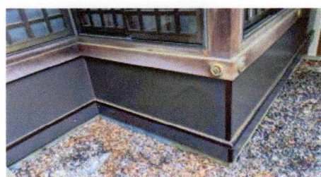
▲ 改修後の様子 ▼改修前 (写真 拝殿北、西側端の土台及び柱)
