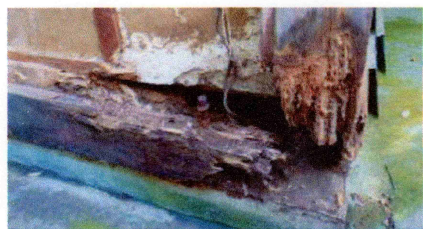
▲ 改修後の様子 ▼改修前 (写真 拝殿北、西側端の土台及び柱)
